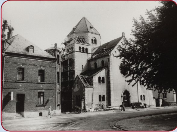
Abbruch der Synagoge
