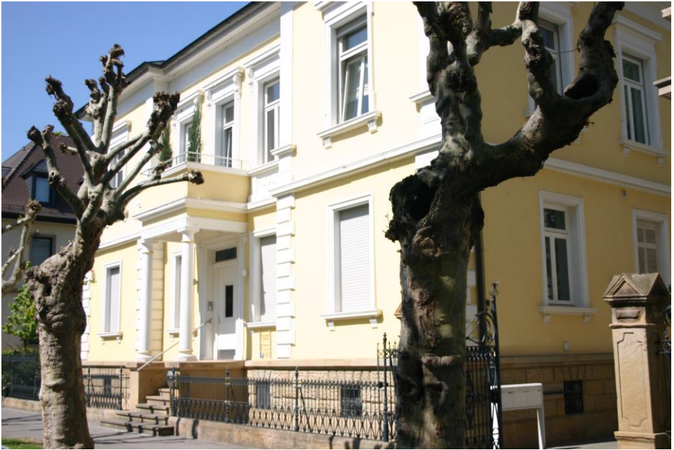
Abb. Das Haus Westliche Ringstraße 29 heute.
