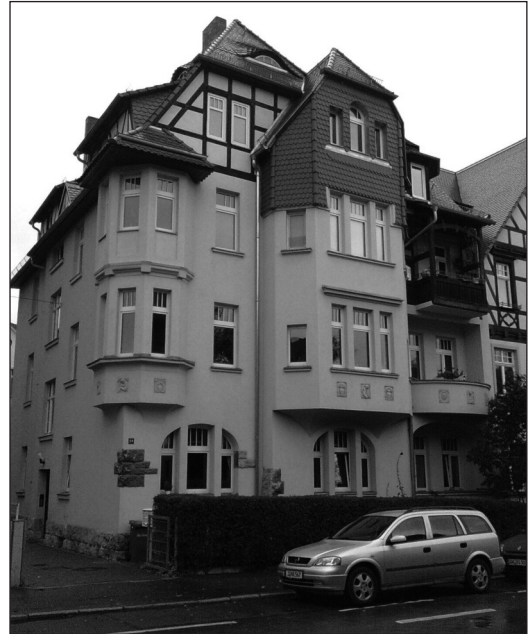
Wohnhaus Erfurter Straße 14 in Jena, 2009.
