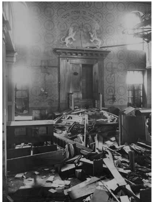
Abb. 5: ... und nach der Zerstörung
