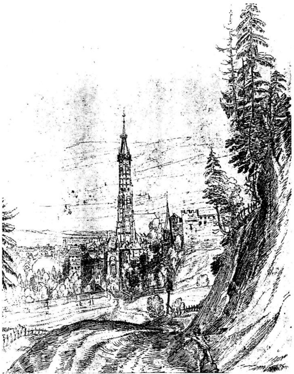
Abb. 4 Die Zeichnung von Frederik van Valckenburg aus dem Jahr 1599 zeigt den gotischen Spitzhelm, der vermutlich beim Umbau 1452 aufgesetzt wurde.
