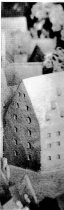
Abb. 3 Die Salvatorkirche trägt hier eine
