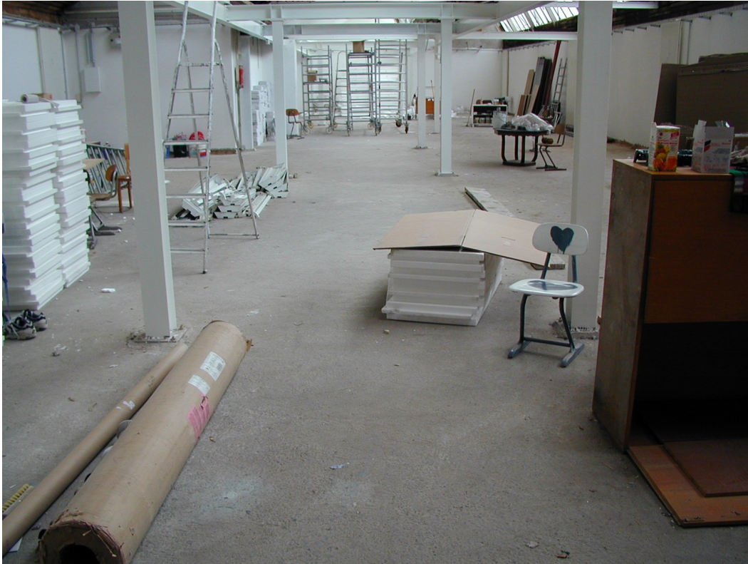
Abb. 48: Sheddachisolierung 226 . Foto: Klaus Schaeffer.
