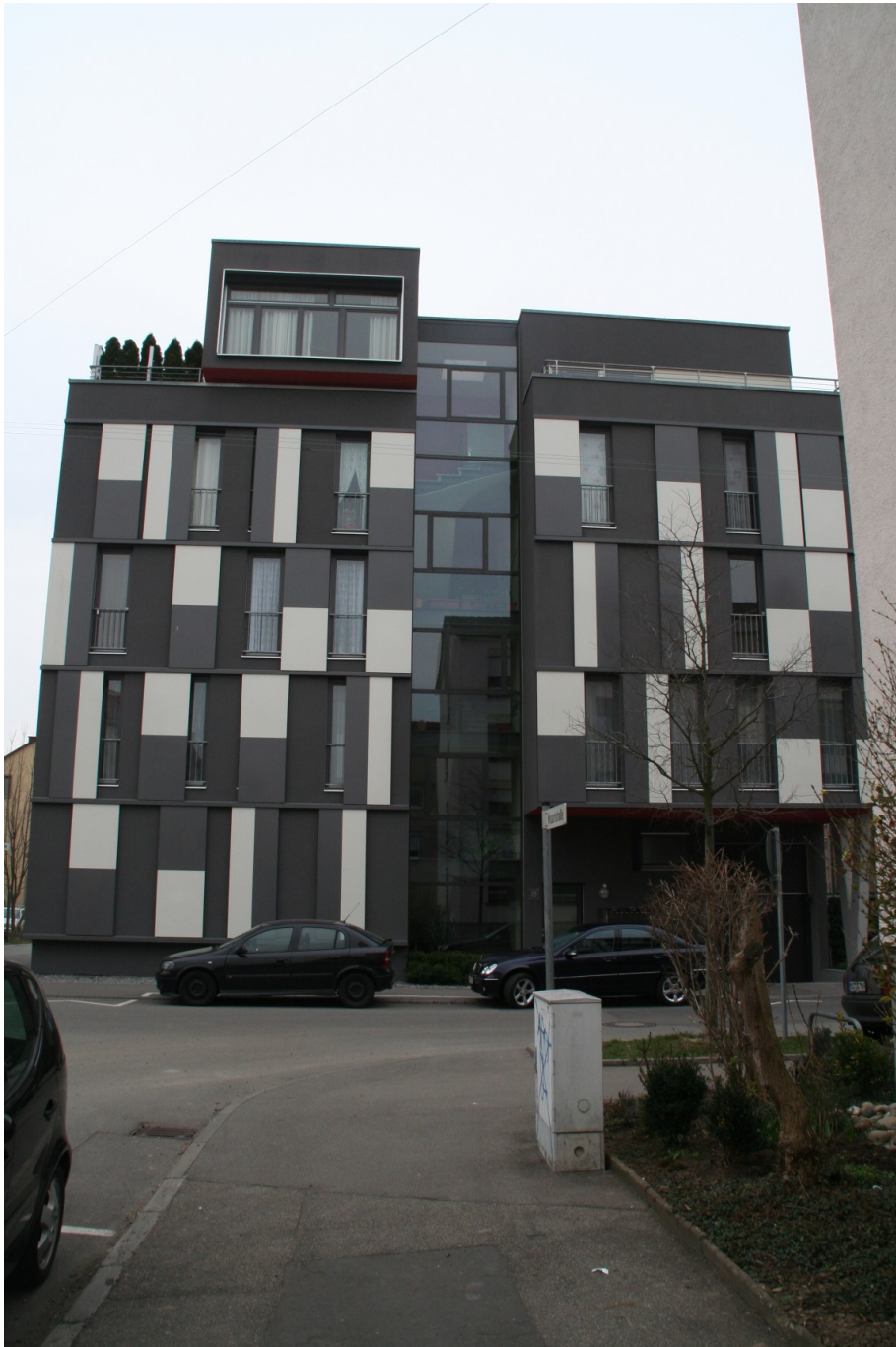
Abb. 41: Auf dem Platz der Baracke steht jetzt das Wohnhaus Achtungstraße 35. Foto: Jung.
