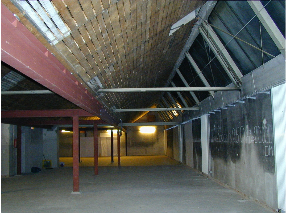
Abb. 47: Sheddach vor der Isolierung 225 . Foto: Klaus Schaeffer.
