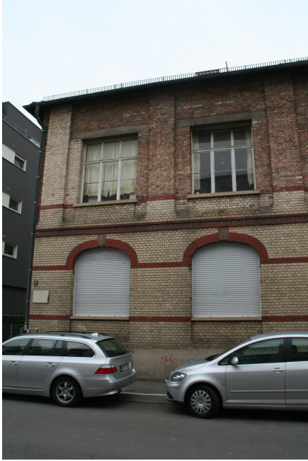
Abb. 7-9: Das Zigarren-Gebäude 2009, aus gleicher Sicht wie in Abb. 6, links die Nordost-Ecke. Deutlich sind die original erhaltenen Außenmauern v. a. im UG und die Ergänzungen aus der Zeit nach dem Zweiten Weltkrieg zu erkennen.
