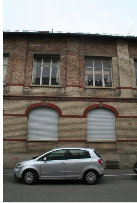
Abb. 7-9: Das Zigarren-Gebäude 2009, aus gleicher Sicht wie in Abb. 6, links die Nordost-Ecke. Deutlich sind die original erhaltenen Außenmauern v. a. im UG und die Ergänzungen aus der Zeit nach dem Zweiten Weltkrieg zu erkennen.
