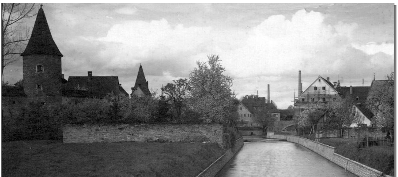
Blick auf die Südmauer. Links der Badturm, im Hintergrund die neue Johannesbrücke mit großer Bogenspannweite, die heute noch so besteht, dazu der neu gefasste Einlass des Stadtbaches und die im Verputz befindliche Kraus-Mühle.
