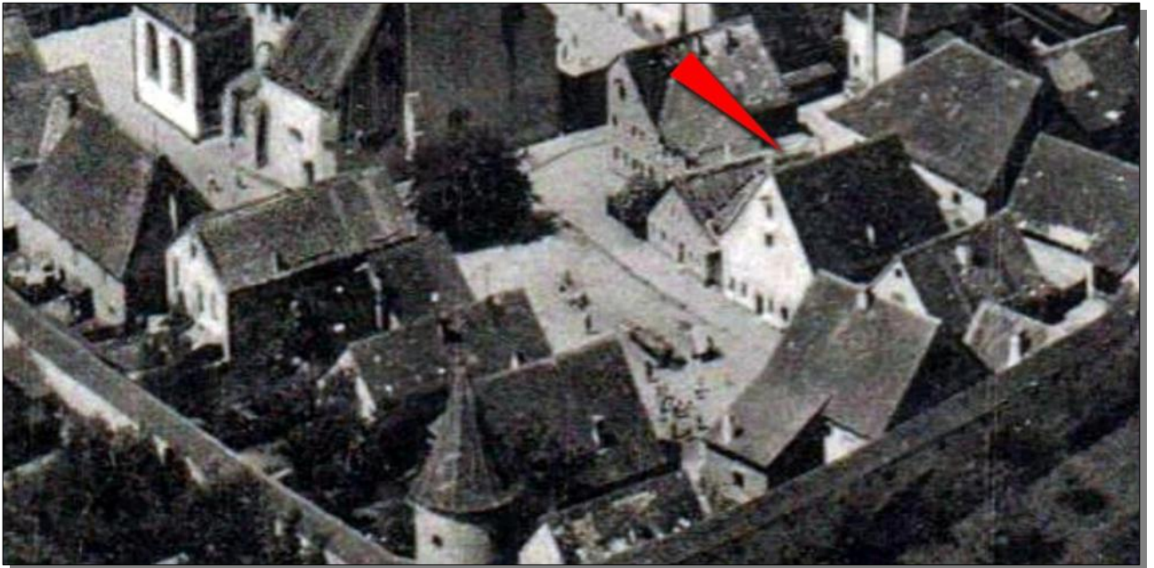
Das Schmelzerhaus (roter Pfeil) auf einer alten Luftaufnahme. Es ist eigenartig, dass der 1. Stock keine sichtbaren Fensteröffnungen enthält. Waren hier die Läden nur geschlossen, oder hat diese „Fensterlosigkeit“ mit der alten Funktion des Schmelzens zu tun?
