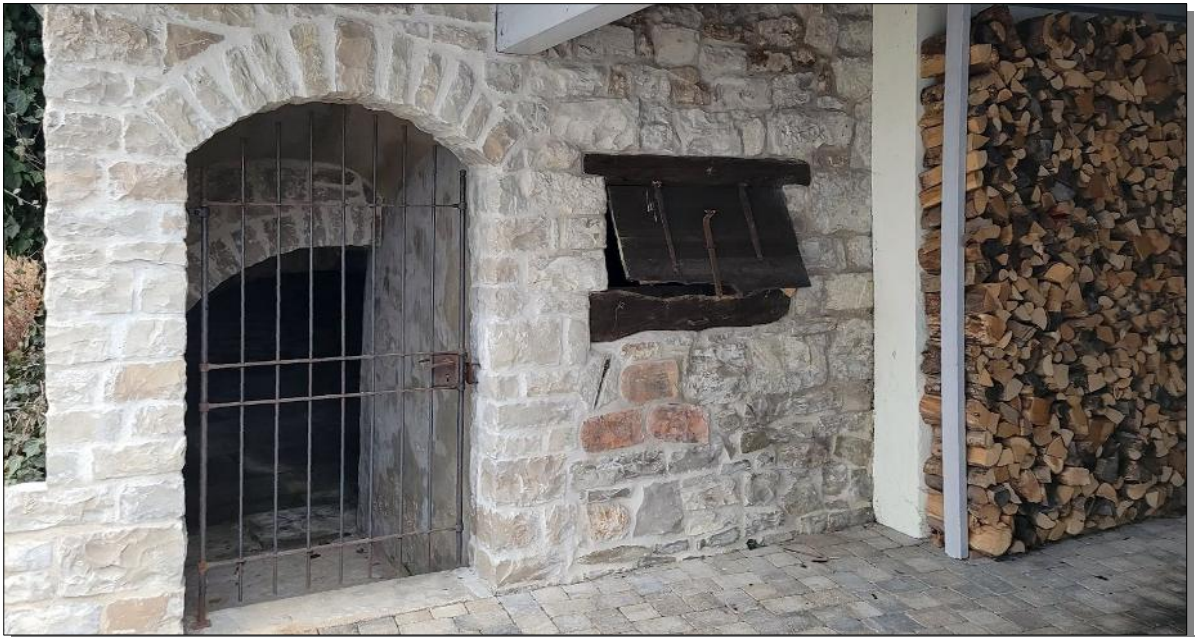
Abgang in den Felsenkeller, rechts daneben die Futterkrippe für Gastpferde. Eingemauert in die Wand erkennt man erhaltene Spolien aus dem Primärbau des Hauses um 1674: einige Dachziegel mit sog. Handstrich, sowie ein großer handgeschmiedeter Zimmermannsnagel mit Öse.
