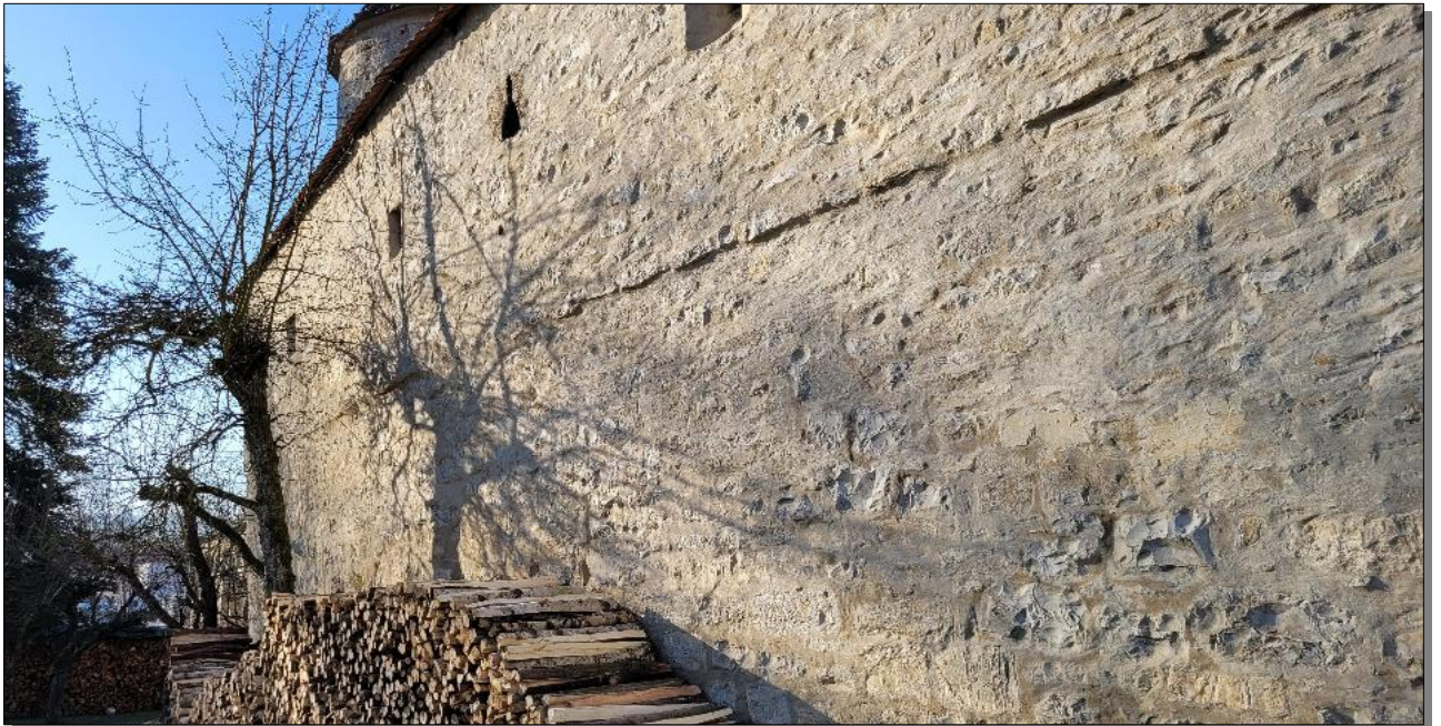
Stadtmauer nördlich des Badturms. Deutlicher Mauerversatz zwischen der ersten und zweiten Stadtmauer Berchings. Oben kleine Fenster und umgekehrte Schlüsselloch-Scharten.
